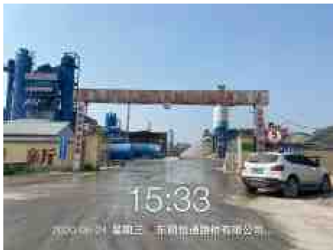
图 3.4-9 东明恒通路桥有限公司沥青搅拌站
