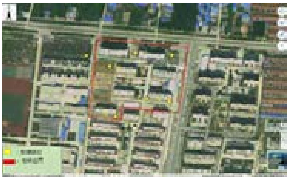
图5.7-1 地块内土壤检测布点
